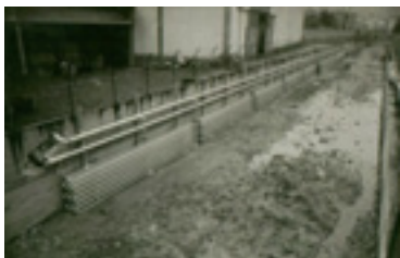
CAPTATORE di calore in roggia - 1962
