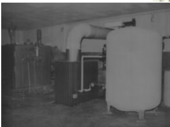
ARIA/ACQUA Bivalente caldaia gasolio-1980
